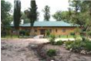
Main house front.jpg
